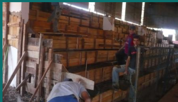
Construcción de las nuevas graderías en el centro parroquial San José Obrero.
